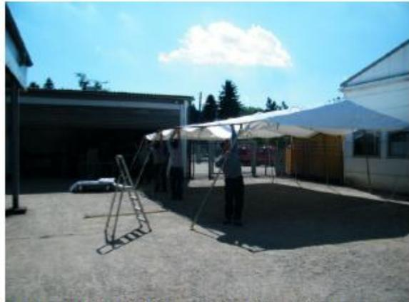
die Dachplane auflegen, auseinanderlegen (Titan Breite 6,00 m die Dachplane links oder rechts am Rand ausrollen, auffalten und über das Zeltdach ziehen).....
