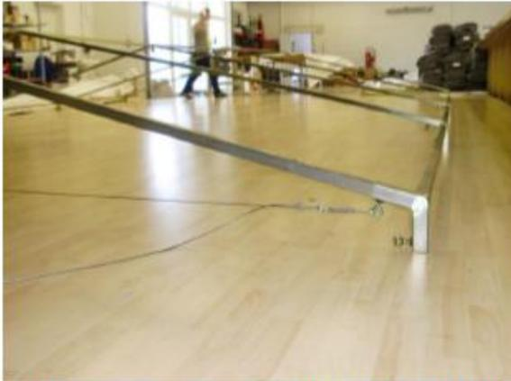
nur bei Titan 6,00 m Breite: den Giebel in der Mitte anheben bis man das Drahtseil mit Spannern in die Flügelschrauben der Außenwinkel hängen kann. Die Spitze in der Mitte des Zeltes soll vom Boden gemessen ca. 90 cm hoch sein, evtl. mit Drahtseilspanner etwas nachspannen, bis Höhe passt. Je ein Drahtseil im ersten, mittleren und letzten Giebel befestigen. Die Drahtseile können wieder entfernt werden, wenn das Zelt komplett steht und fixiert ist.....
